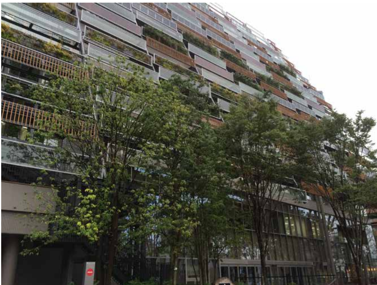
更新後低層提供區公所廳舍使用，高層空間為集合住宅（林宜樺攝影）
