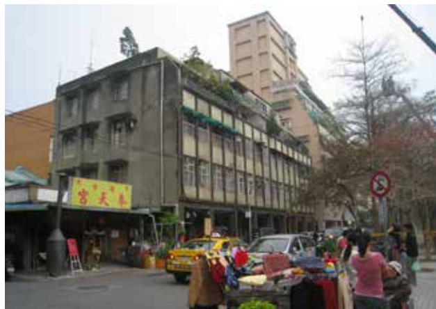
更新前基地東南側台鐵宿舍
