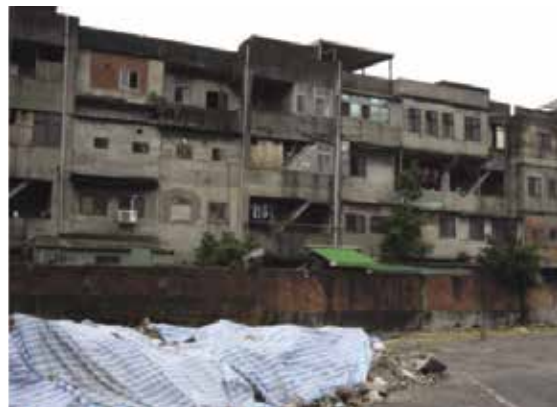
更新前多為四、五層樓老舊公寓
