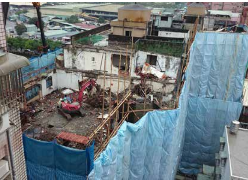
本案於建照核定後拆除危險海砂屋
